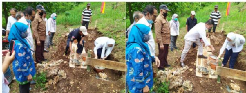
Gambar 10. Peletakan Batu Pertama Pembangunan sumur Pompa dan Kelengkapannya
